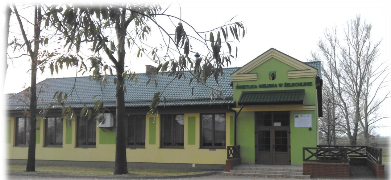
Fot. 20. Świetlica wiejska w Żelechlinie
