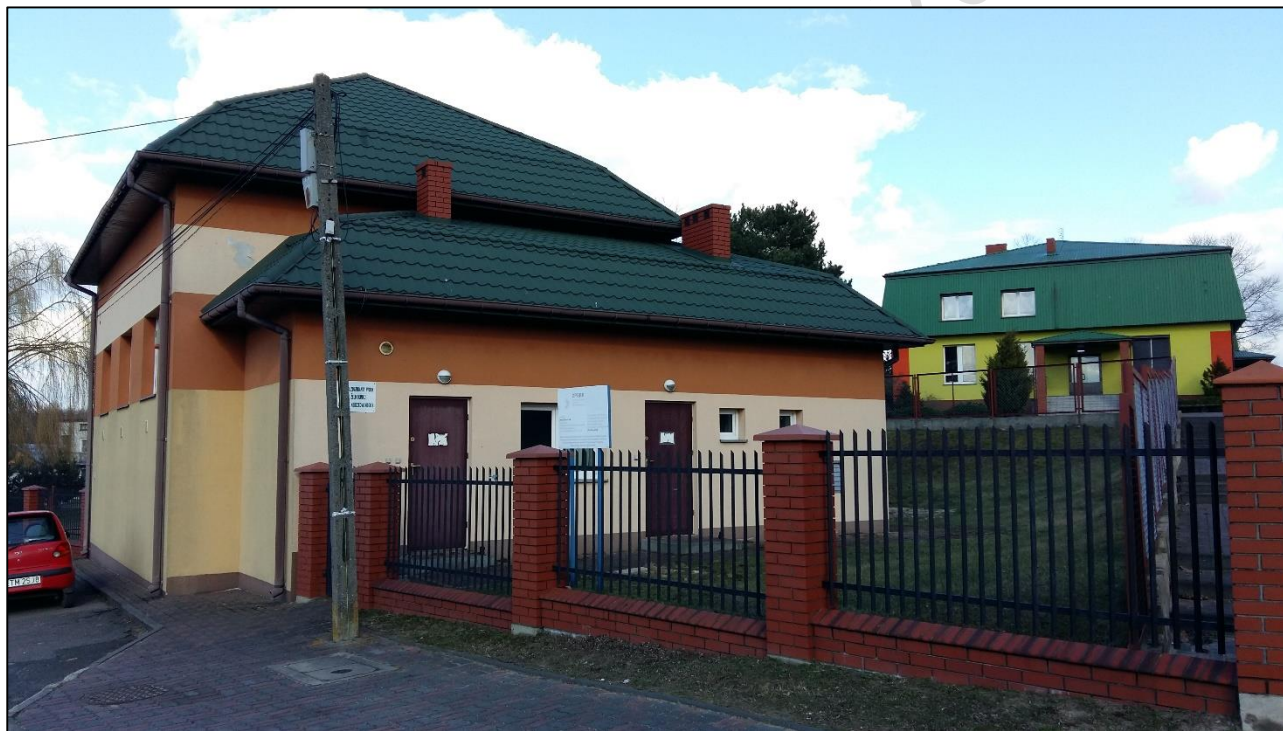
Fot. 25. Stacja uzdatniania wody w Żelechlinku.
